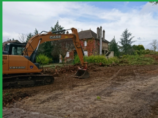
Rue des Créots, un parc arboré masquait cette maison avant ce chantier
